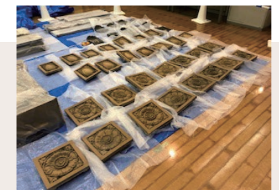
⑯旧建物の外壁から取り外したレリーフ 新建築のインテリアとして再利用
